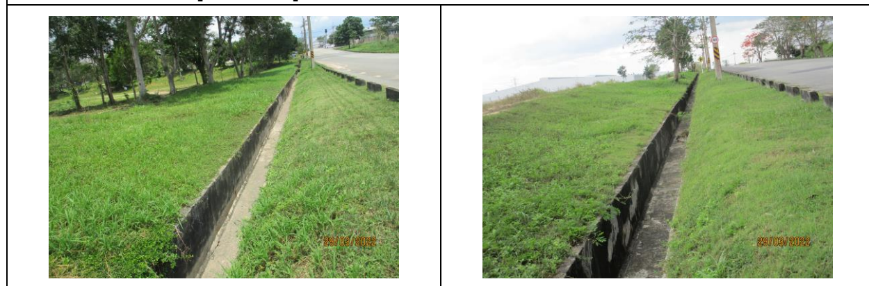
รูปที่ 2 รางระบายน้ำฝนของโครงการ
