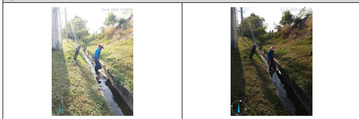
รูปที่ 1 การดูแลทำความสะอาดรางระบายน้ำฝนของโครงการ
